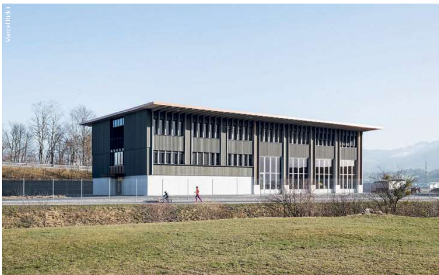
Der stattliche Neubau befindet sich zwischen einem Entwässerungsgraben und dem Damm des Reichenburger Autobahnkreuzes.
