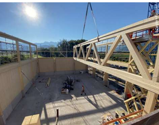
Die beiden in Längsrichtung verlaufenden Fachwerkträger wurden im Juni 2020 montiert.
