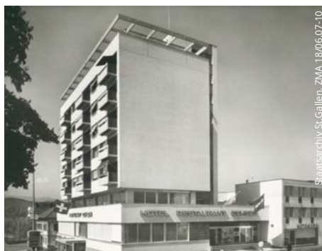
Der 1963 errichtete Komplex mit dem Hotel Ochsen verkörperte den Optimismus der Hochkonjunktur.
